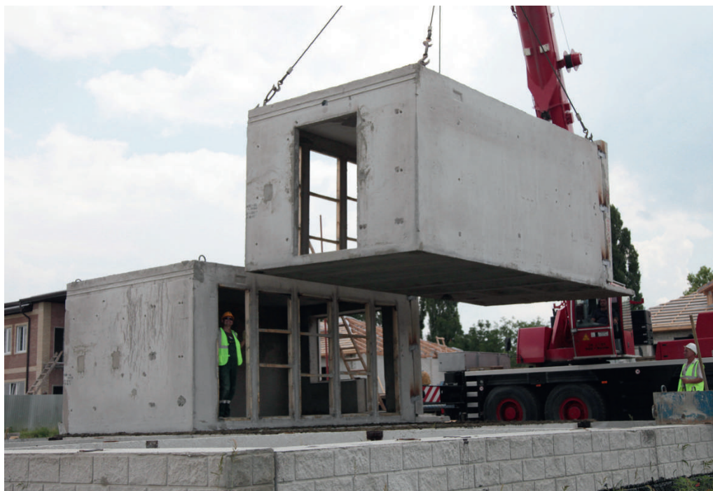
Для сборки на строительной площадке используются краны 40-тонники. Одна блок-секция весит 20 т
